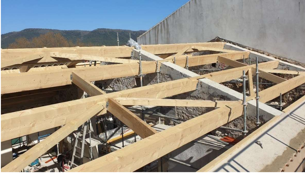
Remplacement de Charpente Ancienne
