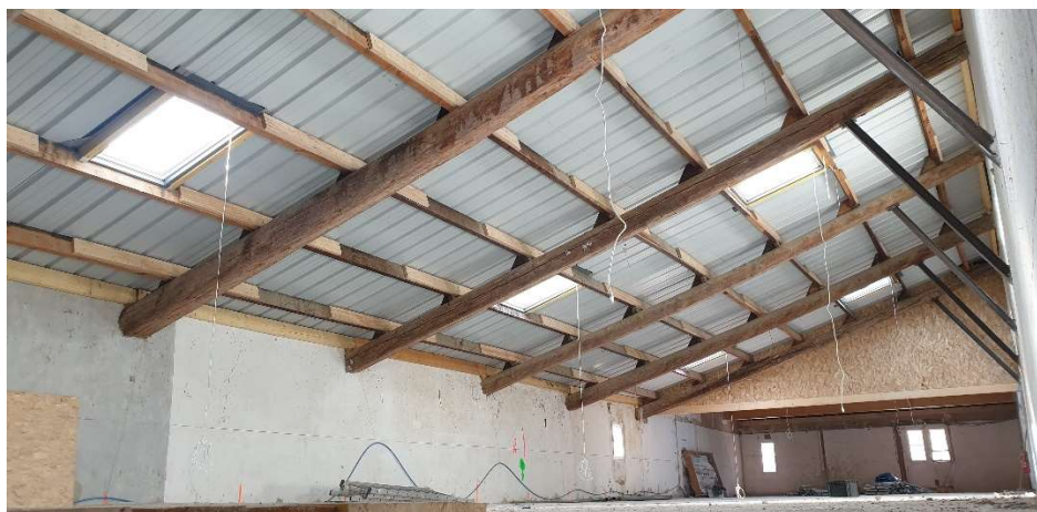
Lamellé Collé et reprise en sous oeuvre
