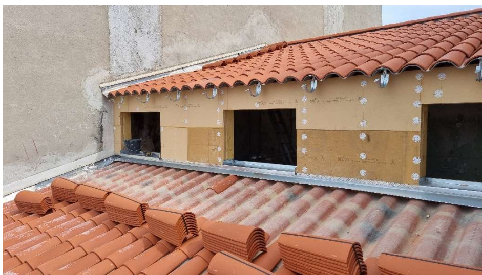
Surélévation Ossature Bois
