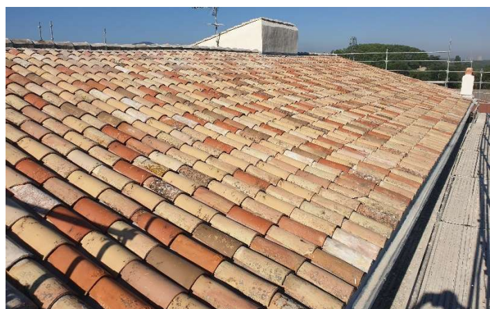
RENOVATION DE COUVERTURE
