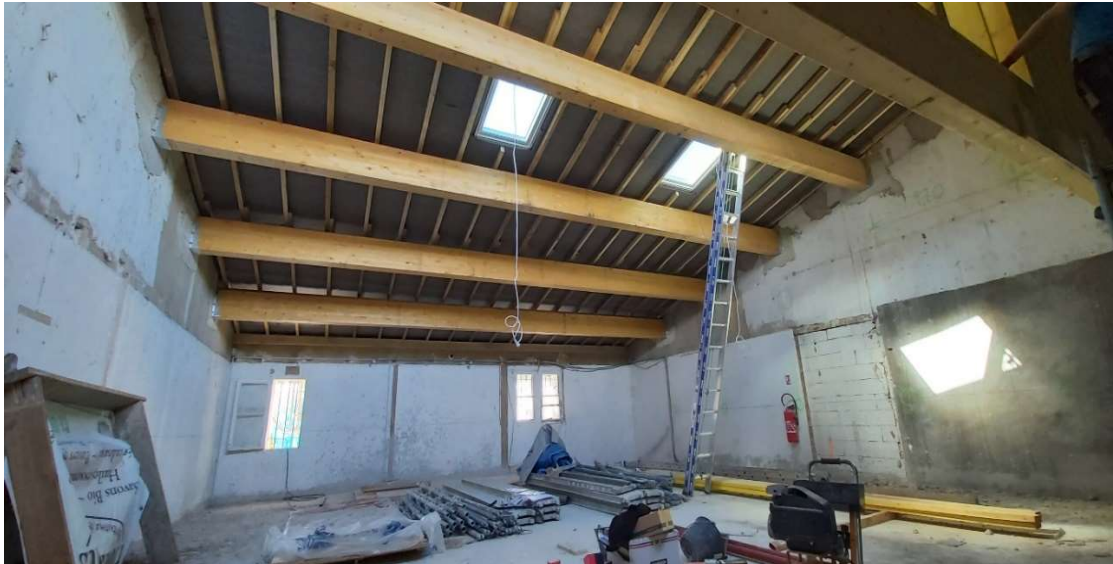
Lamellé Collé et reprise en sous oeuvre
