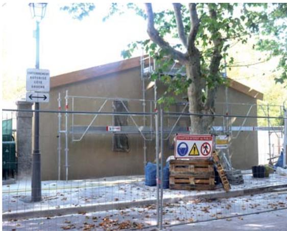
Les travaux de la Maison du Bel âge se poursuivent. A ce jour, la charpente, les menuiseries et l'isolation en béton de chanvre sont terminées. Dans les mois qui viennent, ce sera l'intérieur qui sera mis en place avec le cloisonnement et la finition du sol, puis l'enduit extérieur et enfin les structures extérieures telles que la passerelle, le portillon le garde-corps et les volets viendront clore les travaux.
